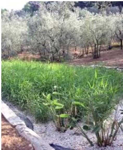
Recentemente si è però sviluppata la tendenza ad utilizzare la fitodepurazione per operare il trattamento terziario di “affinamento” dell’effluente proveniente da un trattamento secondario (generalmente di natura biologica) che, realizzando una prima rimozione delle sostanze inquinanti, riduce questa esigenza di superficie.
