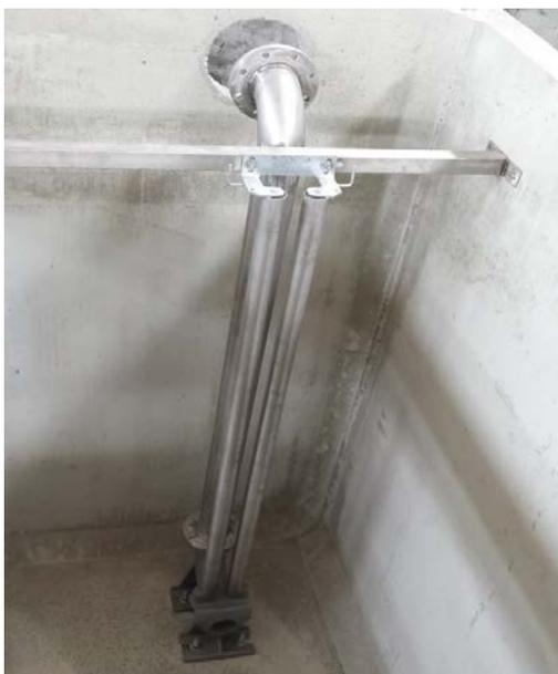
Le pompe sono installate sul fondo con dispositivi di accoppiamento, mentre le relative tubazioni di sollevamento (entrambe provviste di valvola di ritegno) vengono generalmente raccordate ad una singola tubazione di mandata. Su richiesta è possibile fornire anche un ulteriore pozzetto di manovra per agevolare le operazioni di regolazione della portata di rilancio.
