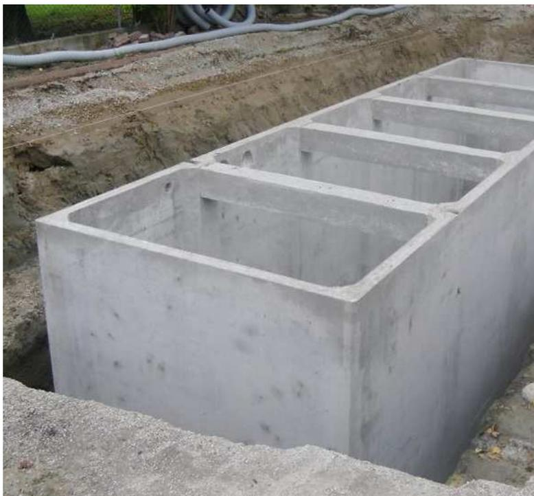
Pertanto le cisterne possono essere utilizzate per l'accumulo di acque pulite (anche potabili), acque meteoriche (utilizzabili a scopo irriguo o per stoccaggi prima del trattamento della prima pioggia), riserve idriche antincendio oppure di acque reflue per accumuli provvisori.
