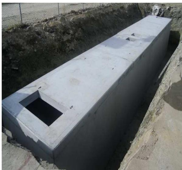
Sulle vasche e i setti interni vengono eventualmente praticate forature di diametro adeguato posizionate in base alle più svariate esigenze, eventualmente dotate su richiesta di flange e manicotti in acciaio inox o giunti in PVC.
